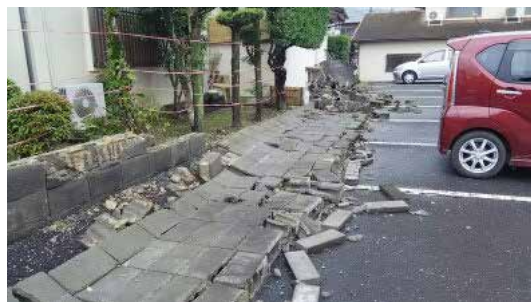
病院職員駐車場、ブロック塀が倒壊
